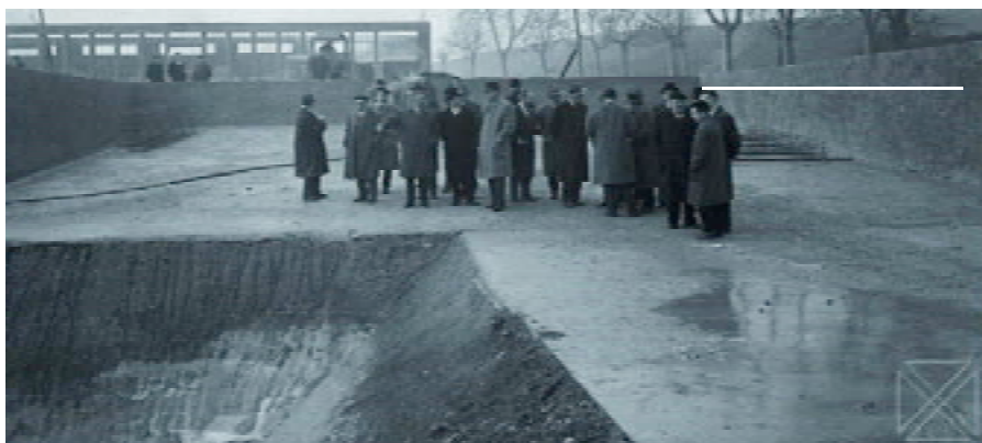
Año 1959. Inspeccionando las obras", La imagen corresponde a la piscina de saltos. A la izquierda se puede apreciar "la fosa" de la zona de los trampolines. el año que viene hará 50 años.
